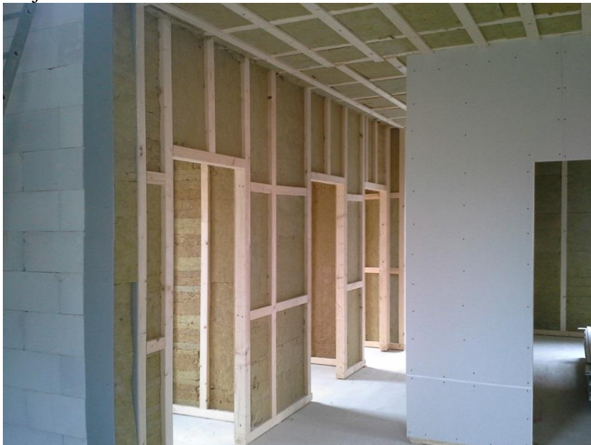
Izdelava pregradnih sten-podjetje Rihter
