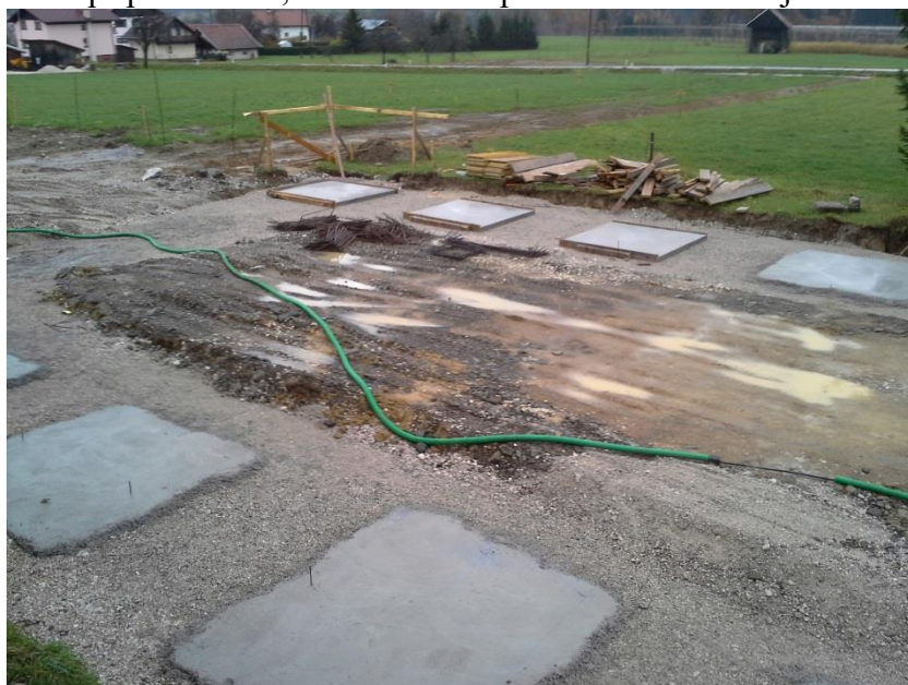
Prvi zametki temeljev
