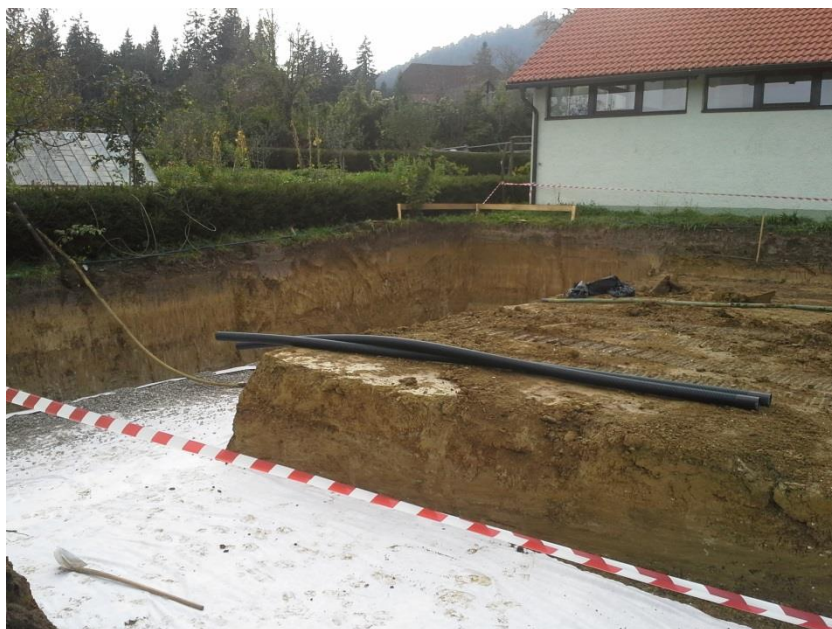
Priprava za temelje
