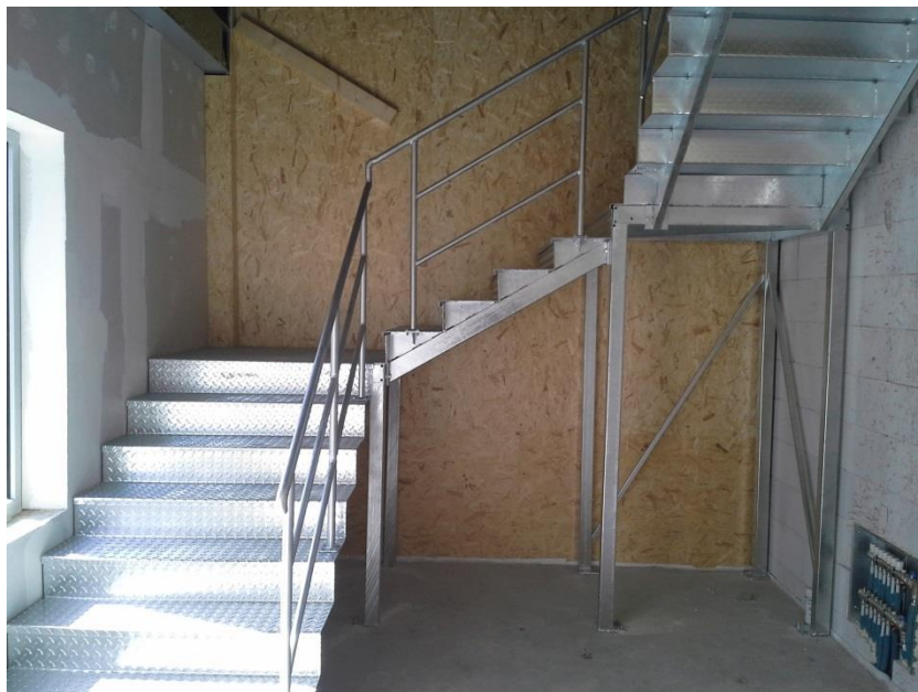
Montaža stopnic-Marki transport-EM PK
