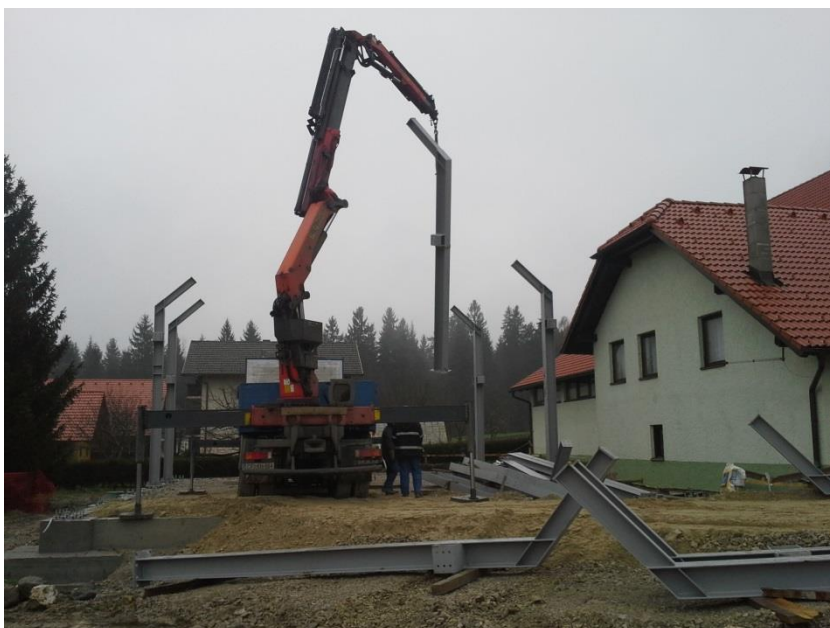
1. Dan montaže jeklene konstrukcije
