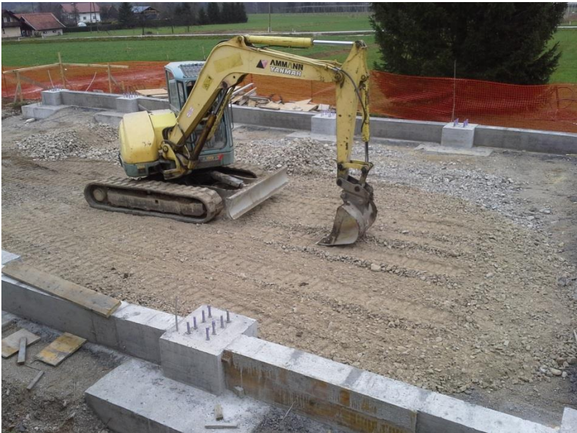
Priprava za temeljno ploščo
