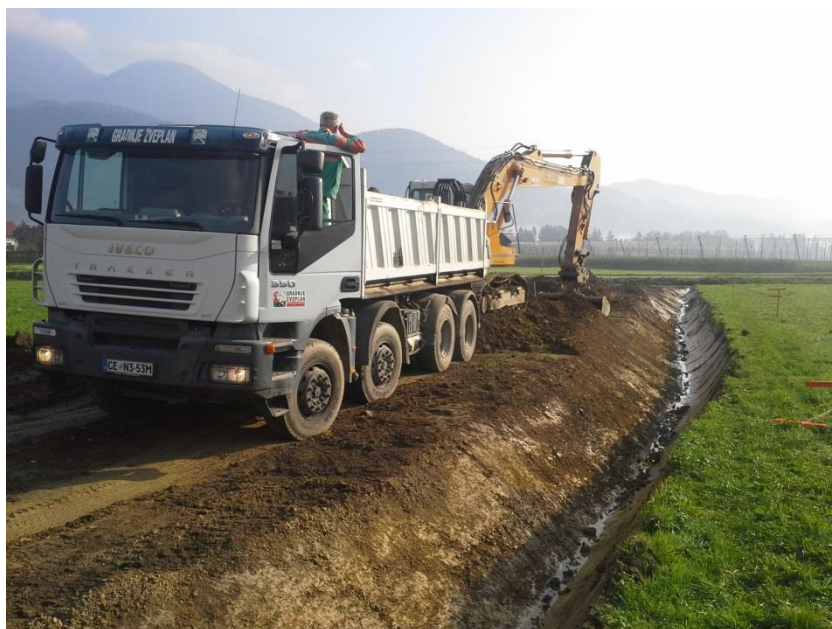
Izkop za odvodnjavanje in priprava za novo cesto
